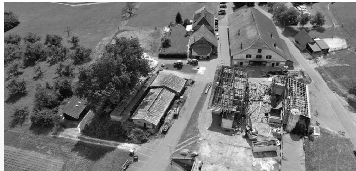
Rückbau von Gebäudeteilen aus Holz (Juli 2017)
